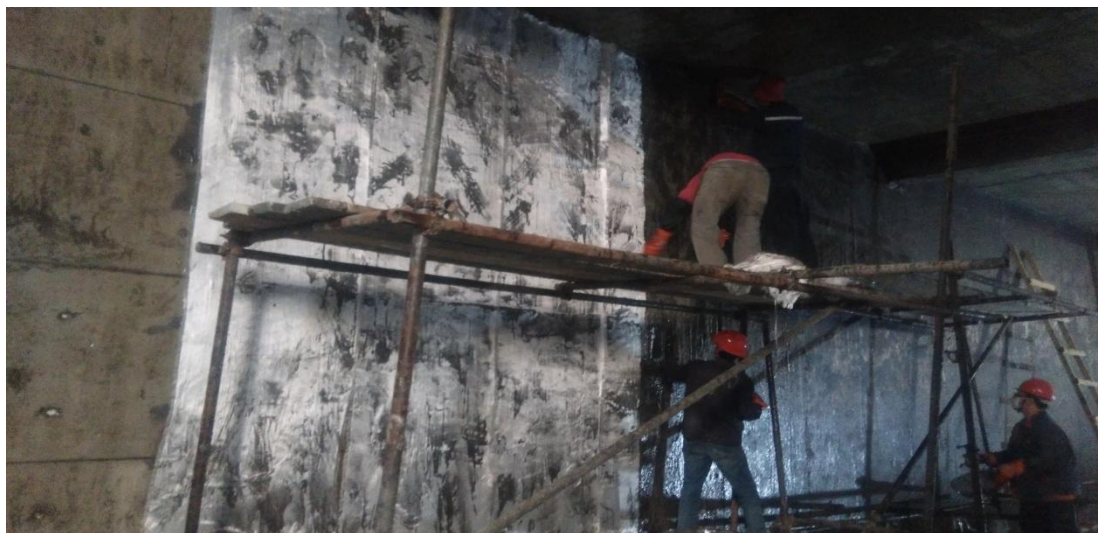
图 4-5 综合水池玻璃钢防渗-----玻璃丝布铺设
