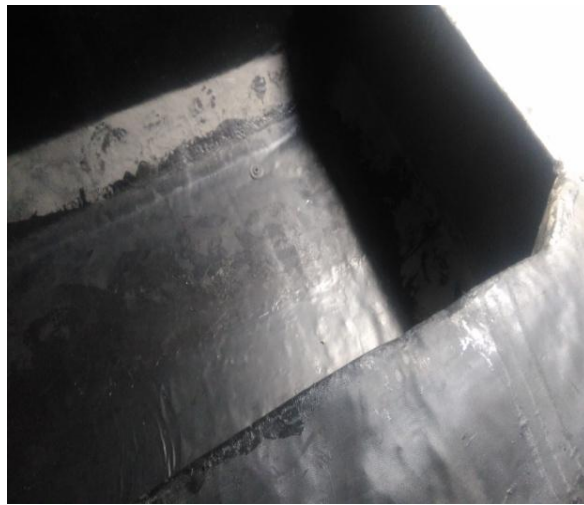
图 4-7 综合水池铺设完防渗层
