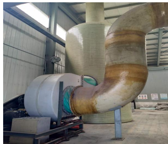
图 4-12 碳酸氢铵配置车间、拆包机粉尘收集管道
