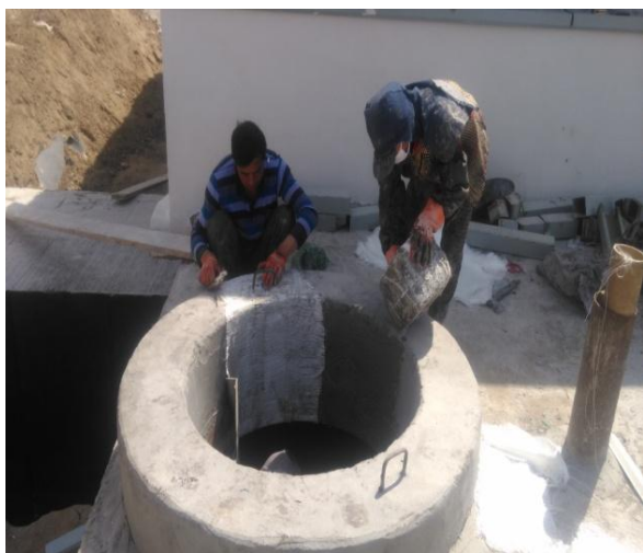
图 4-6 综合水池人孔入口的玻璃钢防渗
