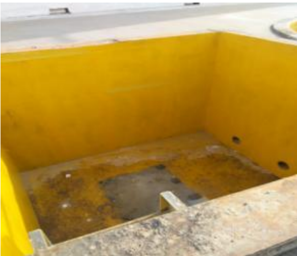
图 4-9 料液池玻璃钢防腐
