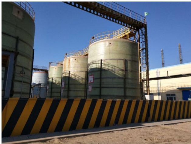
图 4-22 盐酸罐区及围堰
